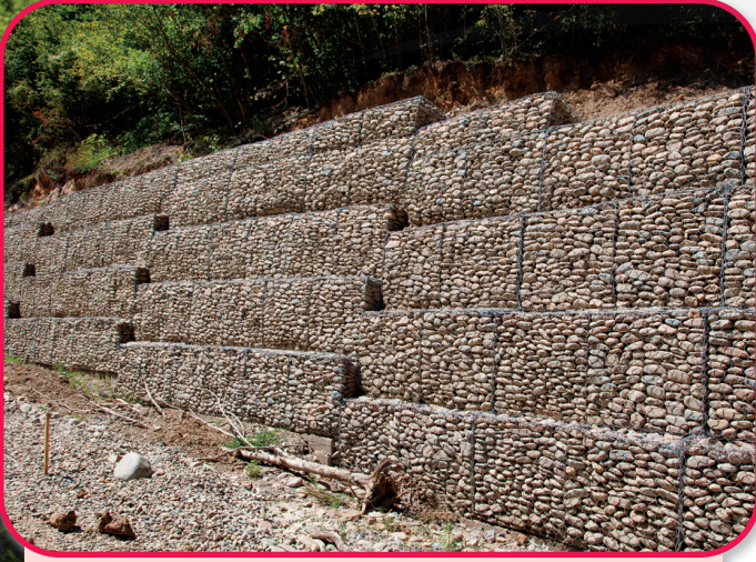
سيحافظُ هذا الجدارُ الصَّخْرِيُّ عَلَى التُّرْبَةِ مِنْ الْانْجِرَافِ أَسْفَلَ الثَّلِّ.
